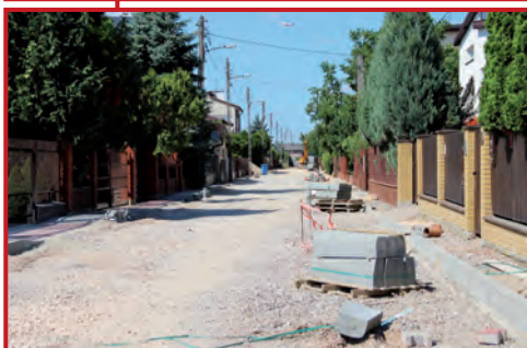
Krawężniki na fragmencie Spacerowej
