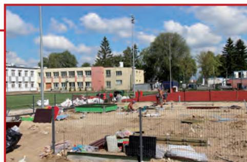
Plac zabaw dla przedszkolaków w budowie
