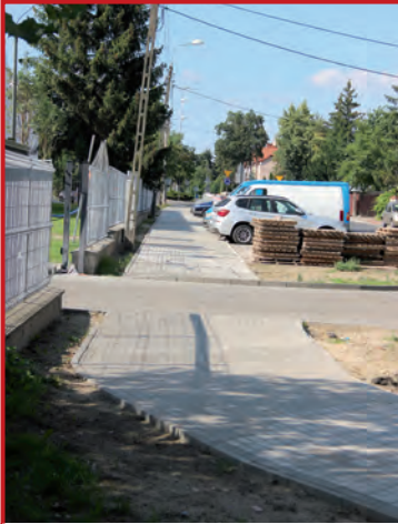
Ścieżka na Stadionowej
