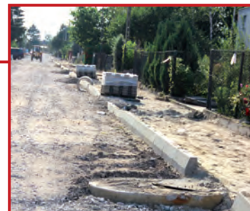
Na Wspólnej rozpoczęto układania krawężników
