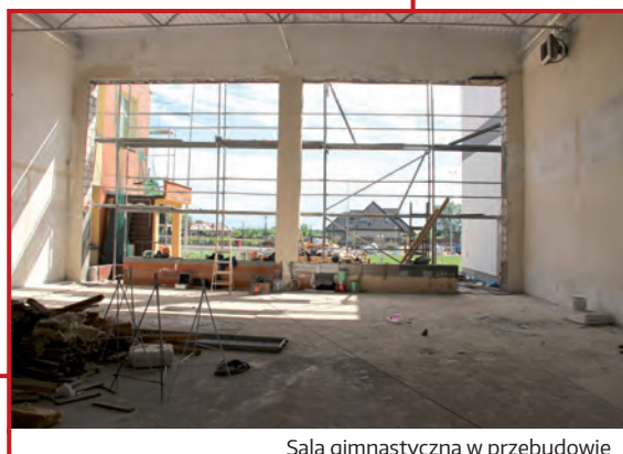
Sala gimnastyczna w przebudowie
