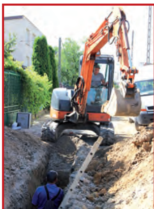
Układanie wodociągu
