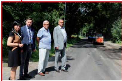
W toku inwestycji
