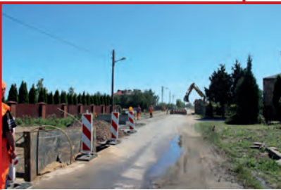
Kanalizowanie ul Wygody
