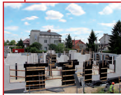
Murowanie ścian
