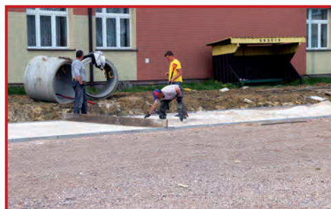
Usypywanie podkładu, fot. J. Kaiper
