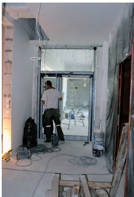
Montowanie drzwi, fot. J. Kaiper
