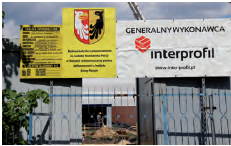
Plac budowy oznakowany przez wykonawcę, fot. J. Kaiper
