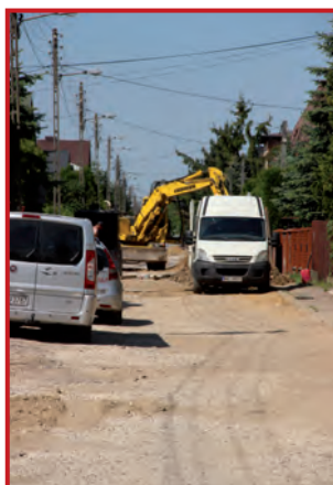
Gruntowny remont Spacerowej
