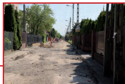
Wykopki na Spacerowej
