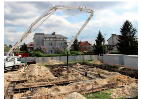
Lanie betonu w fundamenty, fot. J. Kaiper
