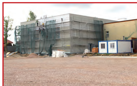
Gruntowanie ścian, fot. J. Kaiper
