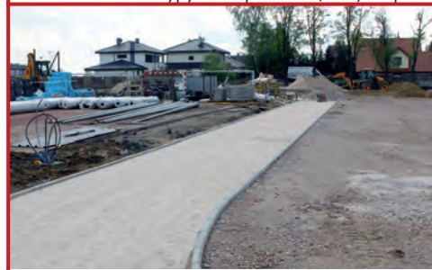
Budowanie bieżni, fot. J. Kaiper
