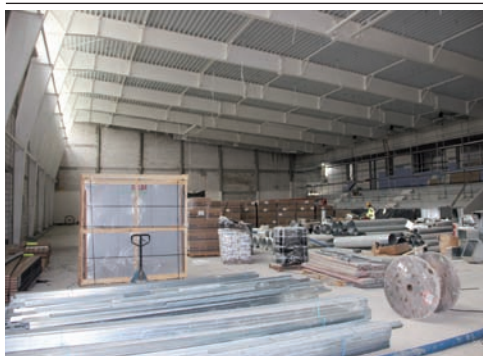
To będzie pod sufitem i na ścianach © J. Kaiper
