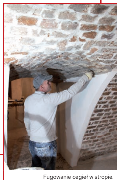
Fugowanie cegieł w stropie.
