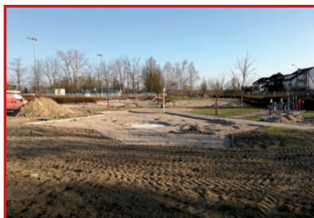
Fundamenty pod wieżę.
